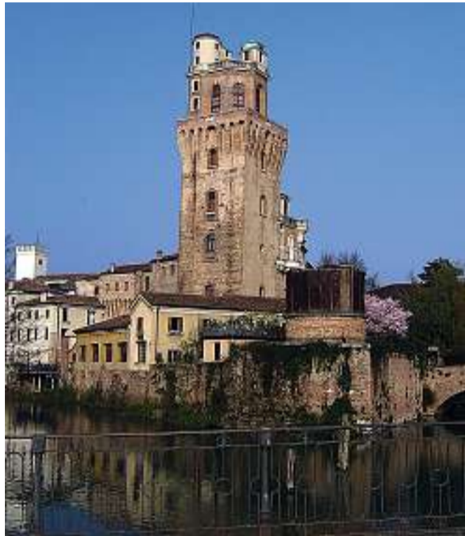
La Specola di Padova. Fu Giuseppe Toaldo a trasformare il bastione del vecchio castello nella torre dell'Osservatorio
