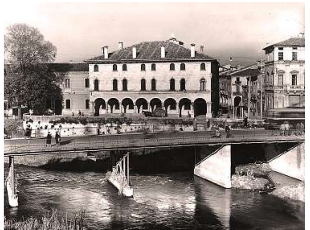
Il penultimo rifacimento di ponte degli Angeli nel 1889: l'inondazione del 1882 lo aveva lesionato
