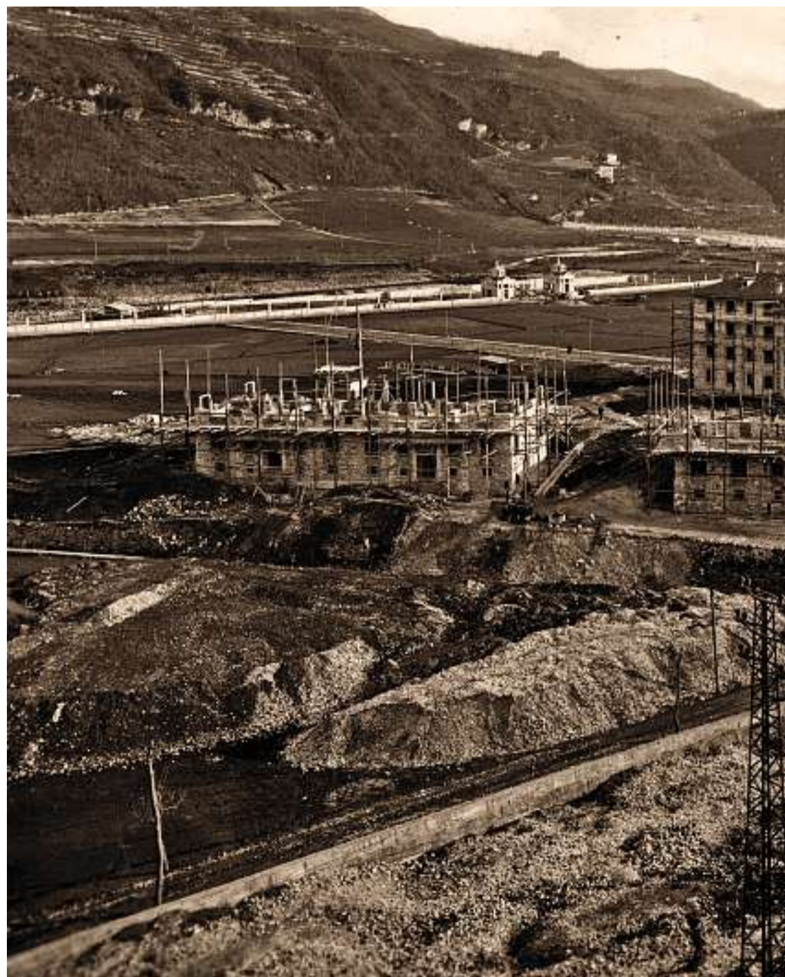
Il nuovo quartiere che sarà denominato "Città Sociale" in costruzione. Il progetto è dell'architetto Francesco Bonfanti, m
